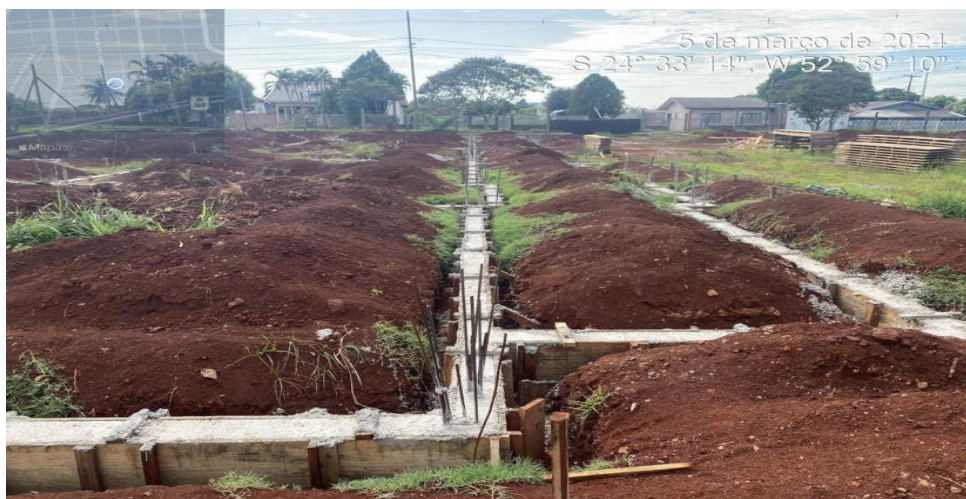
Figura 08: Fundação do novo CMEI.
