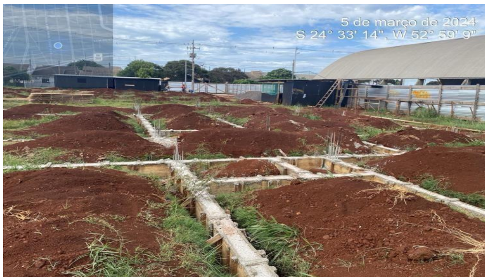
Figura 09: Fundação do novo CMEI.
